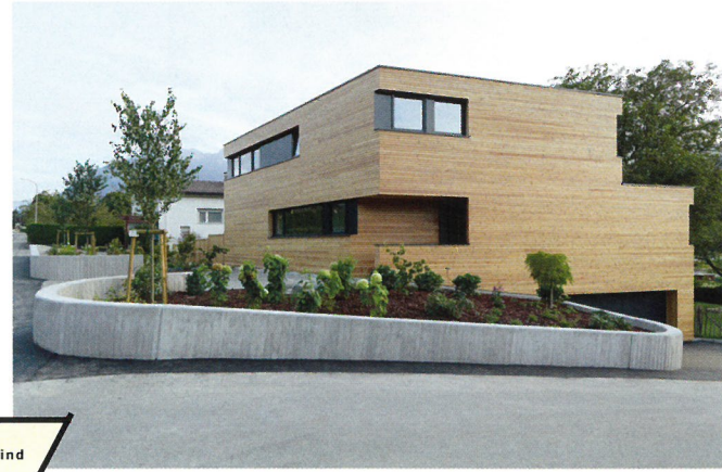
Das flach gedeckte Haus birgt ein ausgeklügeltes Raumprogramm und punktet mit natürlichem Wohnklima.
