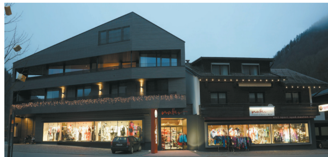
Zwei Gebäude wurden vereint. Die Geschäftsflächen bilden das verbindende Element.
